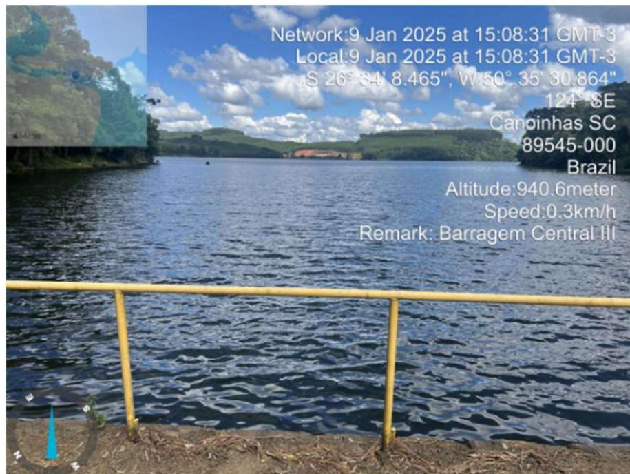
Figura 54 RESERVATÓRIO TRECHO CENTRAL
