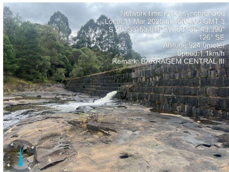
Figura 13 PARAMENTO A JUSANTE
