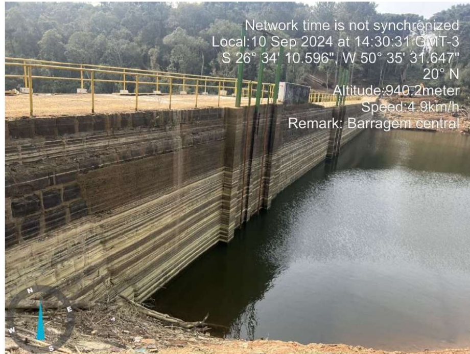
Figura 21 PARAMENTO A MONTANTE
