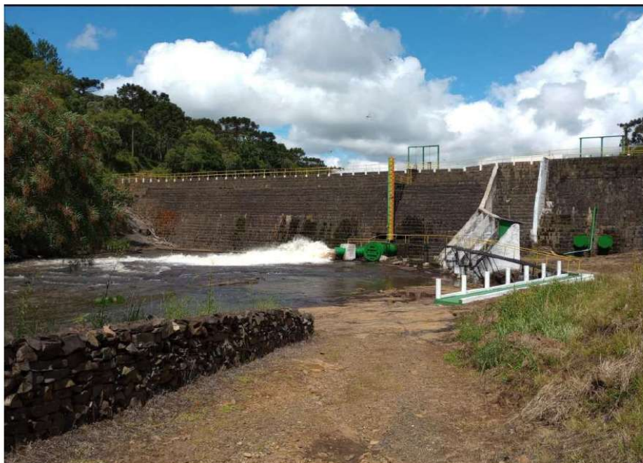
Figura 14 ACESSO À BARRAGEM
