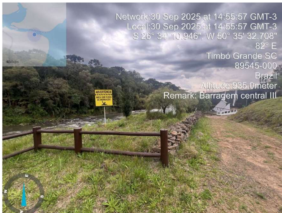
Figura 18 ACESSO À BARRAGEM
