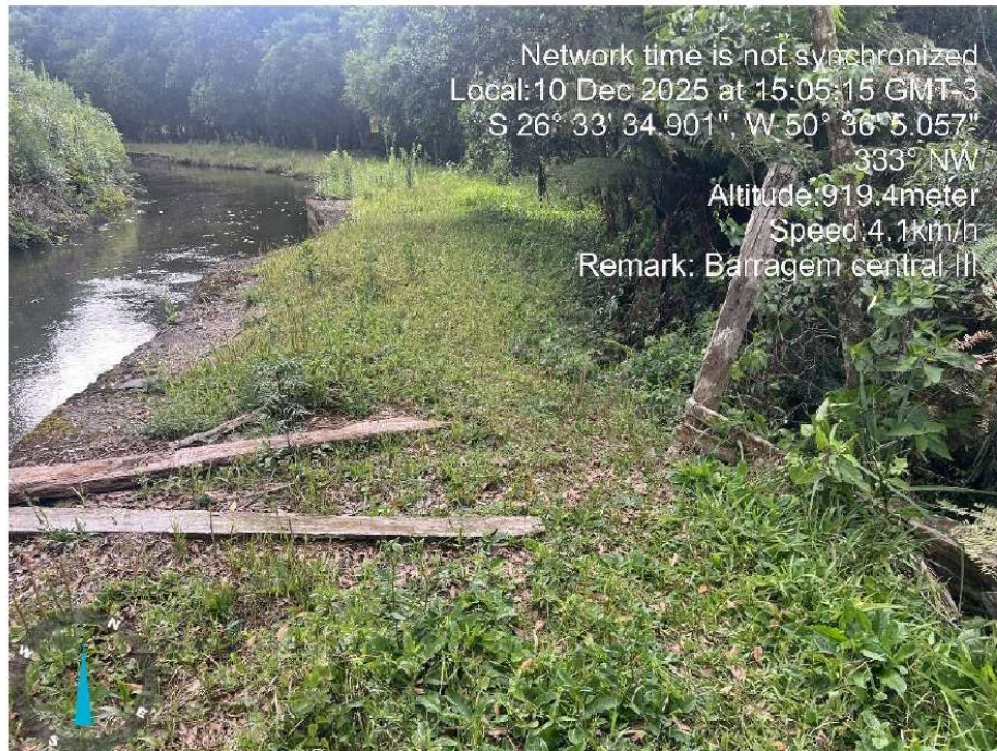
Figura 25 RESIDUOS DE MATERIAL DE MANUTENÇÃO
