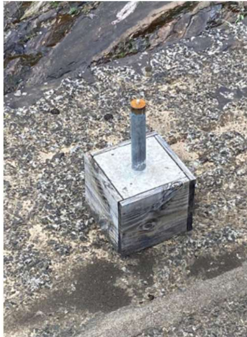
Figura 36 MARCO SUPERFICIAL PARA MEDIÇÃO DE DESLOCAMENTO
