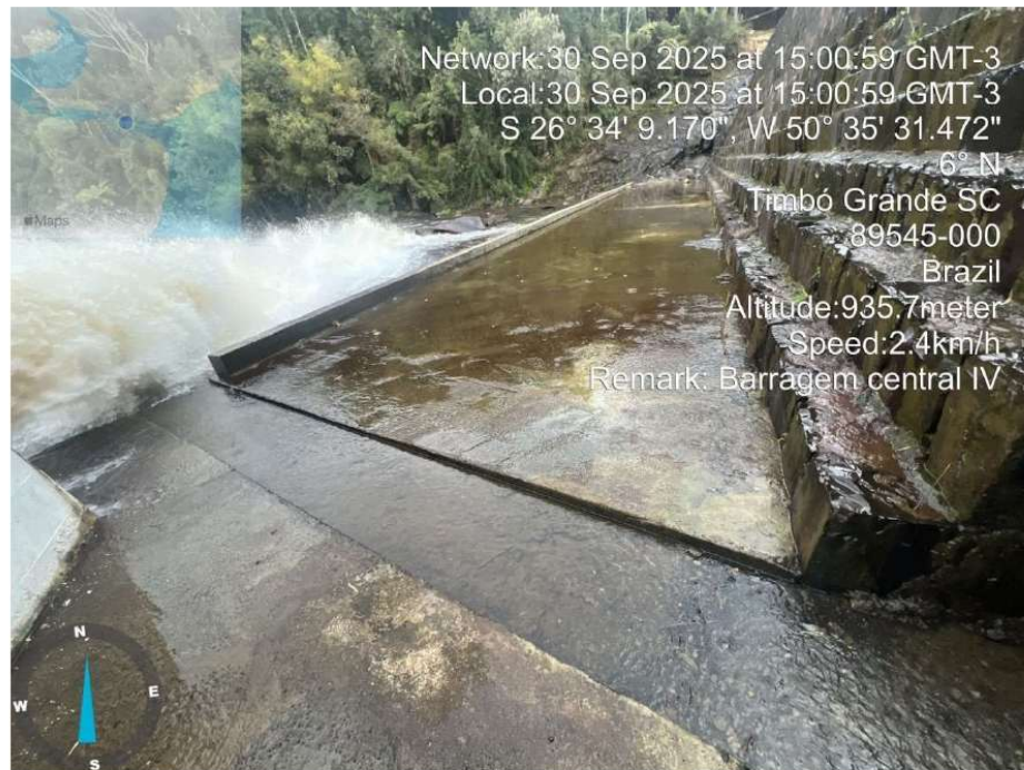
Figura 46 BACIA AMORTECEDORA 02
