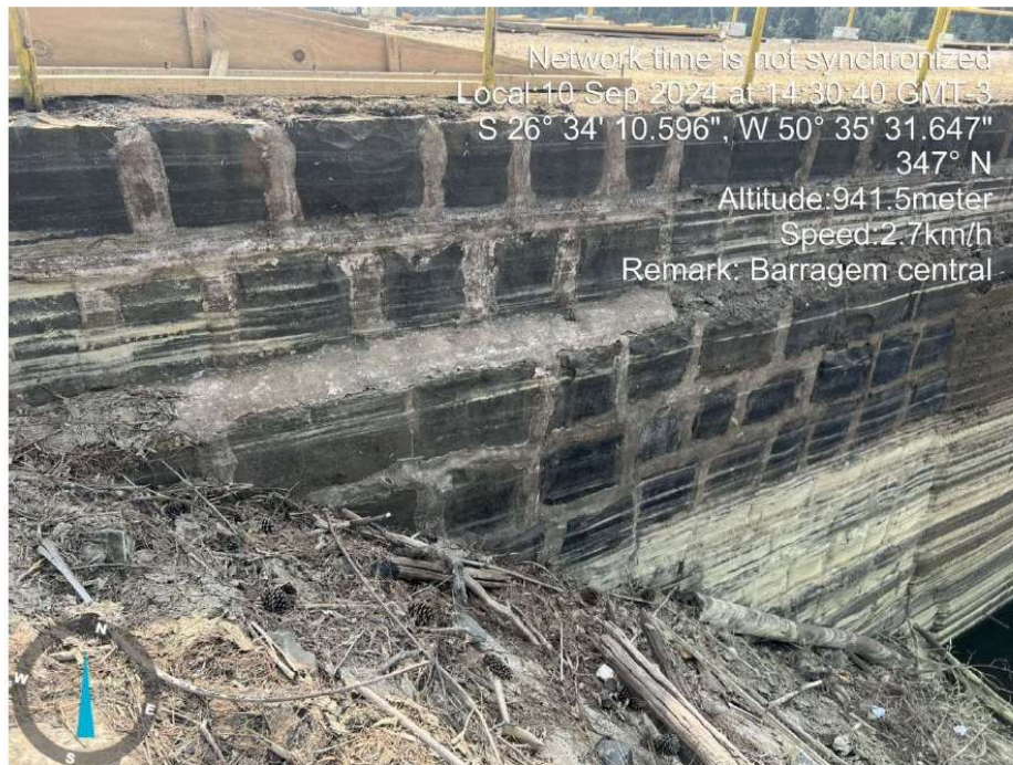
Figura 20 PARAMENTO A MONTANTE
