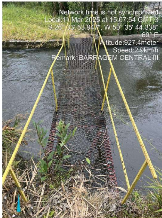
Figura 20 PONTE A SER REESTRUTURADA
