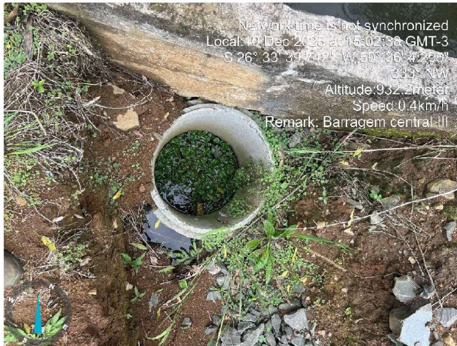
Figura 37 DRENO ENTUPIDO
