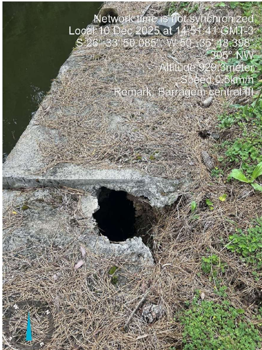
Figura 52 DESLIZAMENTOS DE TALUDE COM DESCOLAMENTO
