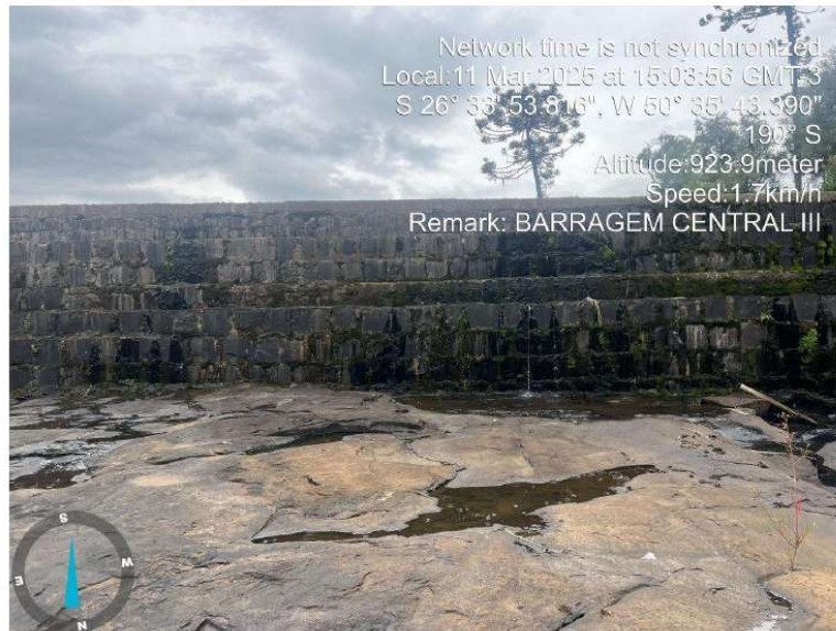
Figura 12 PARAMENTO A JUSANTE
