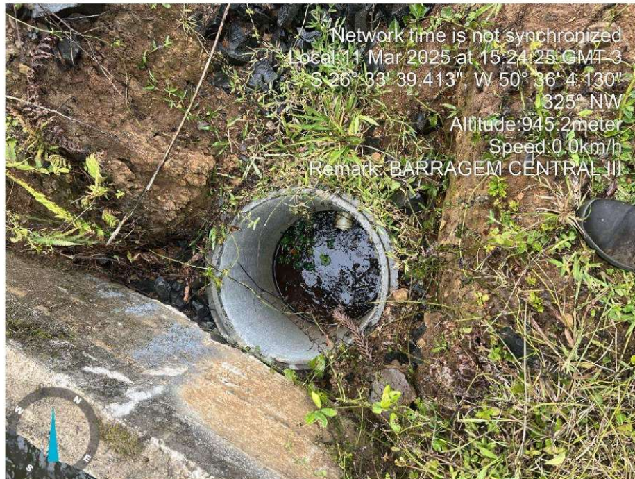
Figura 57 ESTRUTURA DRENANTE DE SURGENCIAS
