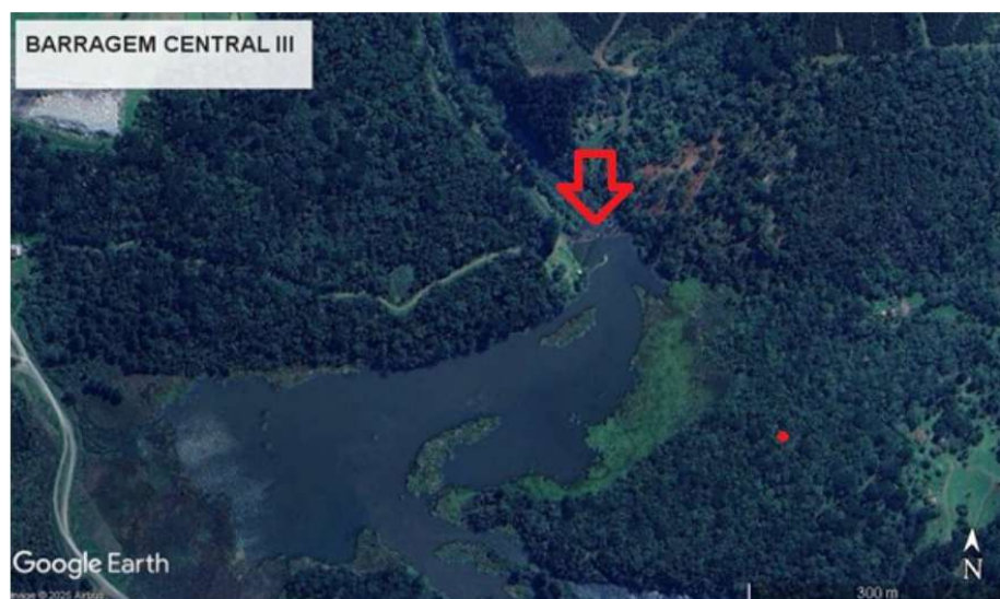
Figura 1 LOCALIZAÇÃO BARRAGEM CENTRAL III
