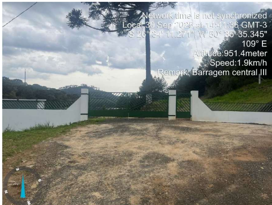
Figura 11 PORTÃO DE ACESSO FECHADO
