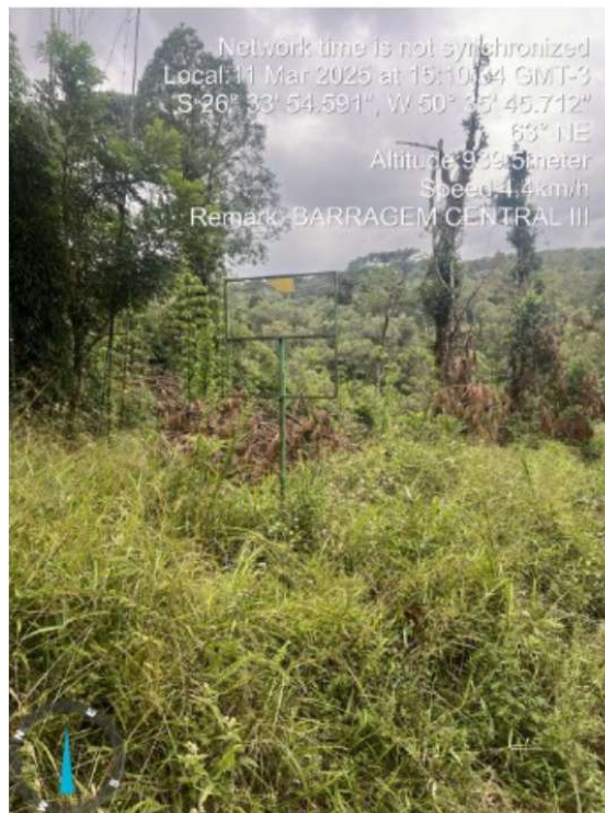
Figura 5 PLACA ORIENTATIVA VANDALIZADA
