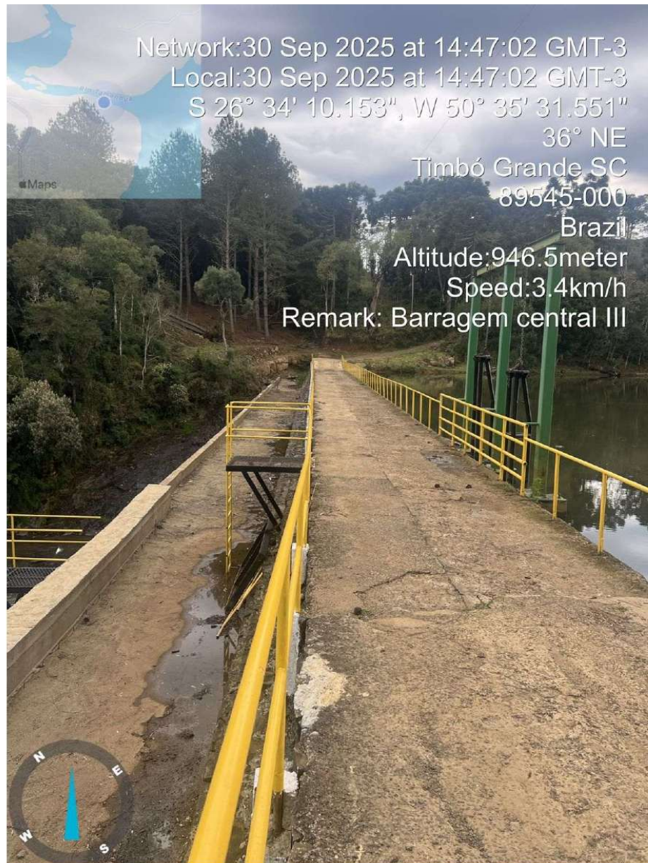
Figura 23 ALINHAMENTO BARRAMENTO CRISTA
