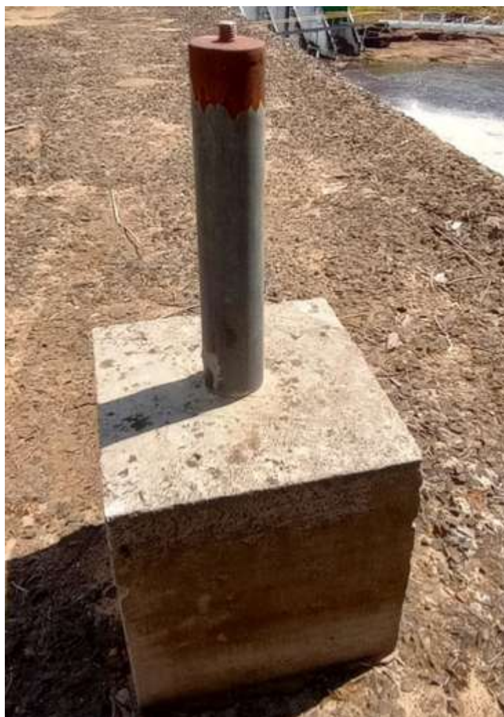
Figura 12 BLOCO SUSTENTAÇÃO BASE DE MEDIÇÃO
