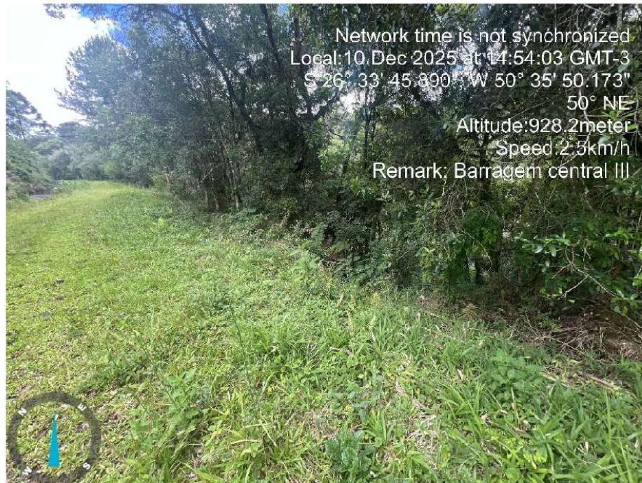
Figura 33 PERDA DE TALUDE
