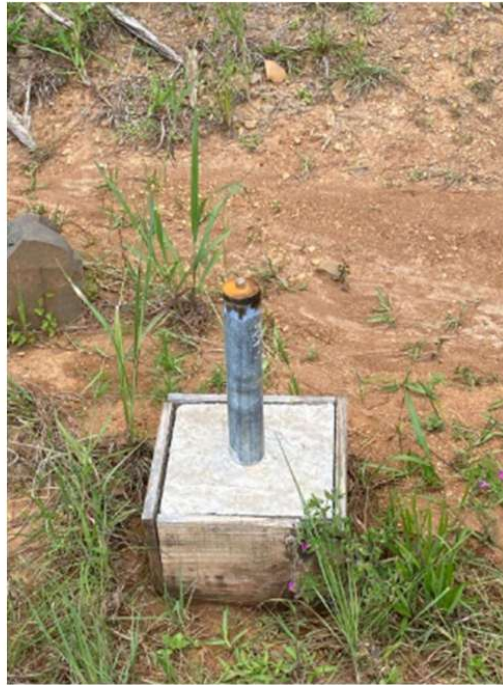
Figura 39 MARCO SUPERFICIAL PARA MEDIÇÃO DE DESLOCAMENTO
