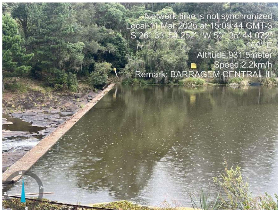
Figura 8 PARAMENTO A MONTANTE
