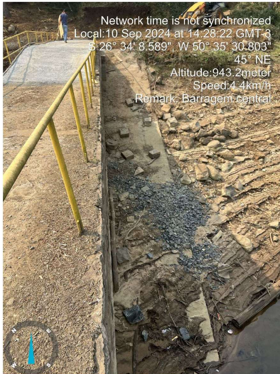
Figura 22 PARAMENTO A MONTANTE
