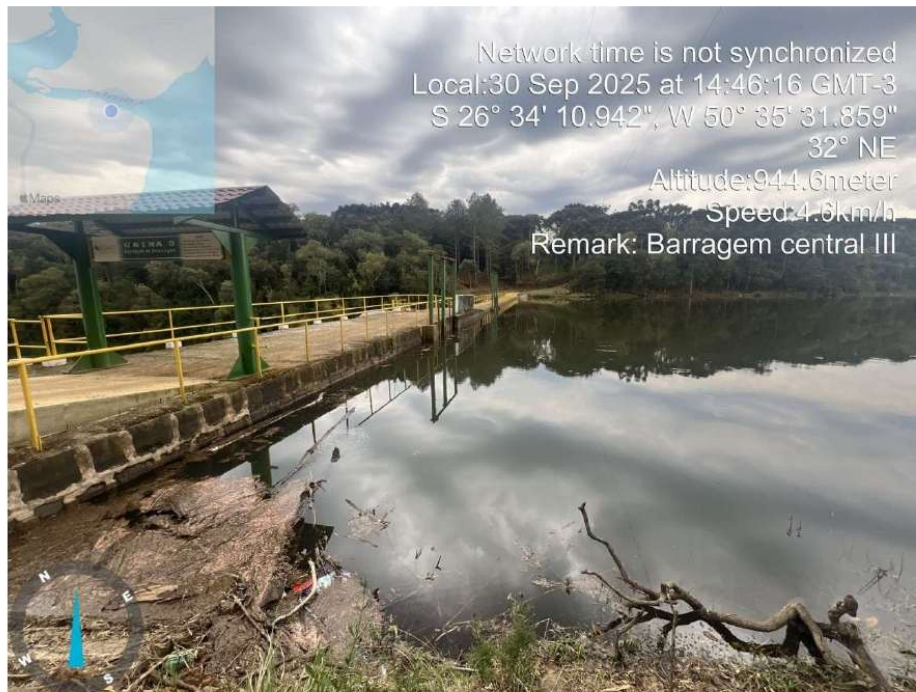
Figura 52 RESERVATÓRIO LADO ESQUERDO
